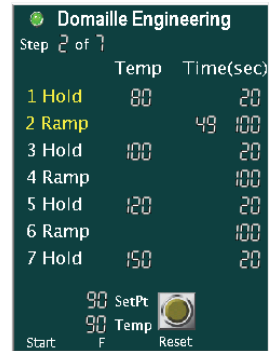
FIG 21. Step & Ramp Step Indicators
